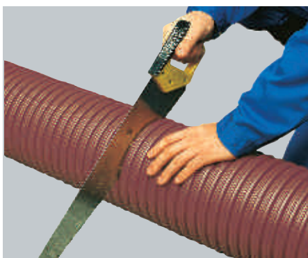
Overskæring af rør – montering af tætningsring
