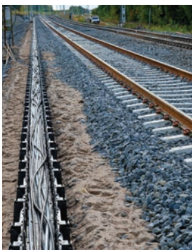
Åben Railduct ved montering
