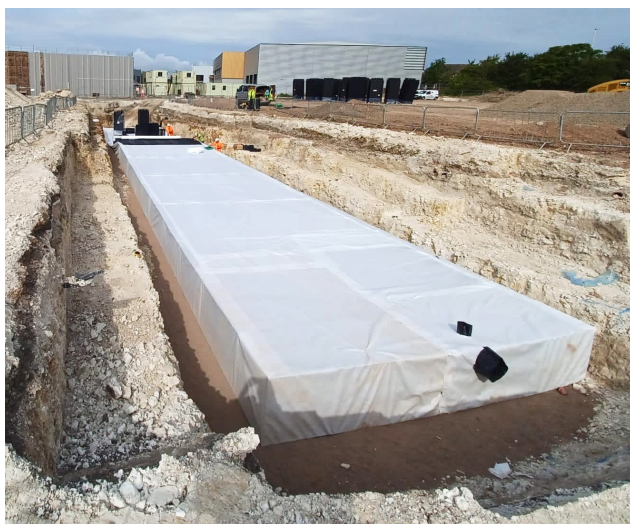
Installation med geotekstil-infiltration
