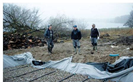
Etablering af biologisk sandfilteranlæg til 30 pe på Arreskov slot.
